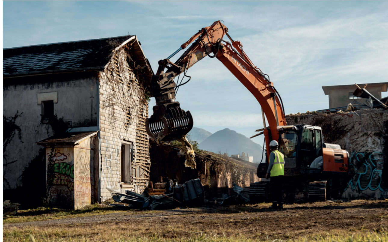
Lauréate de l'appel à projet « Recyclage des friches en Occitanie » la CCHB réalise une opération de réhabilitation de la friche industrielle de l'ancienne porcelainerie (au fond du site Soulé) afin de créer de nouvelles surfaces foncières permettant d'accueillir de nouvelles activités économiques (voir p. 38 - développement économique).
